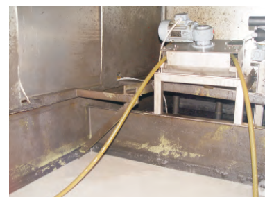
W40 pour d'épuration des eaux résiduaires
